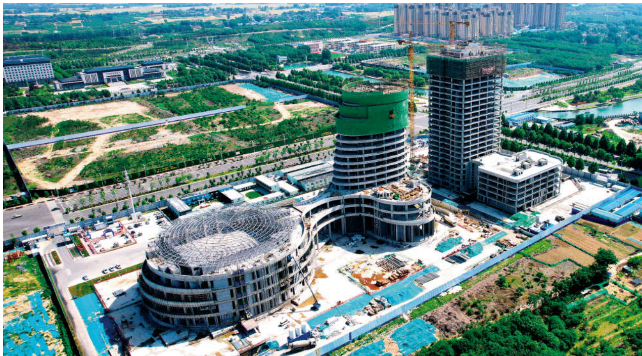
位于示范区的市大数据中心项目 高峯人 侯科健 / 摄
