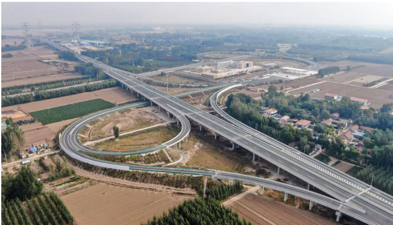
2023年12月，阳新高速二期工程濮阳东互通区。
