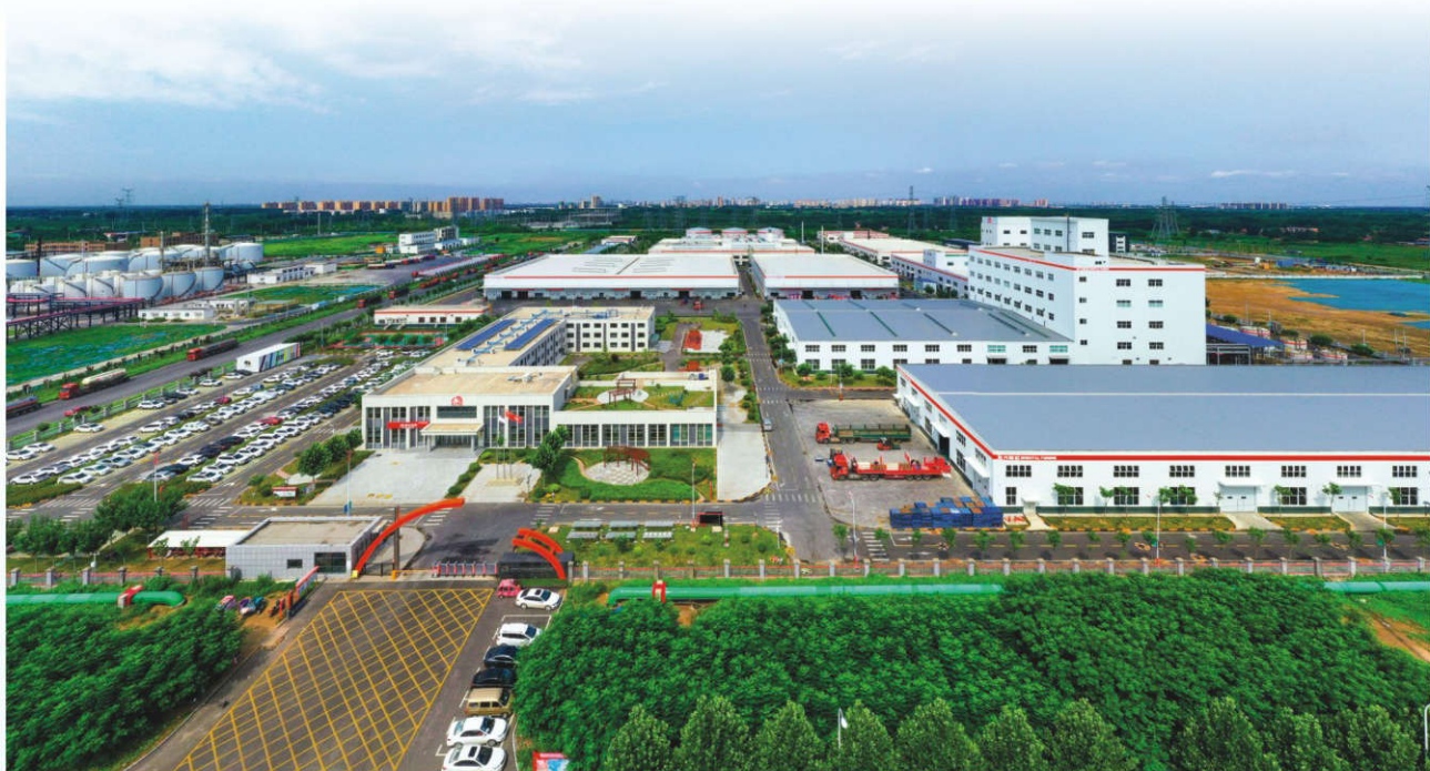
河南东方雨虹建筑材料项目
