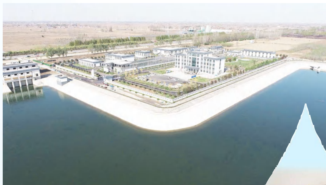
12月22日,随着范县中州水厂开闸放水,我市范县、台前县群众吃上了清澈甘甜优质安全的丹江水,这标志着我市实现了丹江水全覆盖,全域实现了农村供水规模化、市场化、水源地表化、城乡一体化的“四化”目标。
