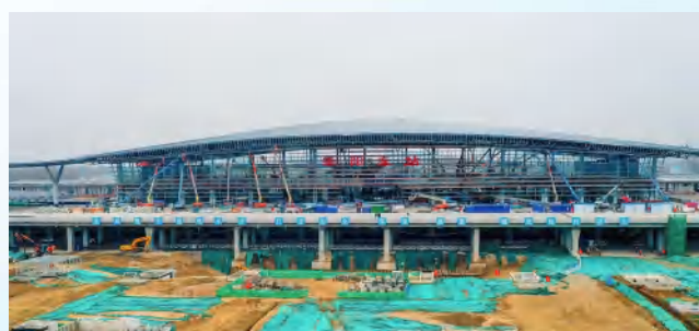
濮阳东站完成站名安装工作。
