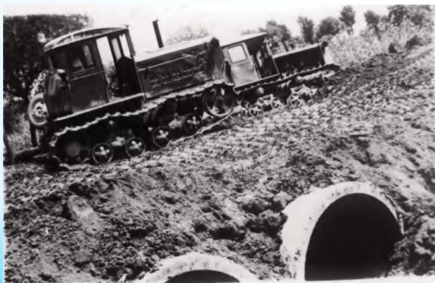
着濮阳市城市建设正式揭开大幕。 八月十七日,市城区胜利路路基开挖,标志
