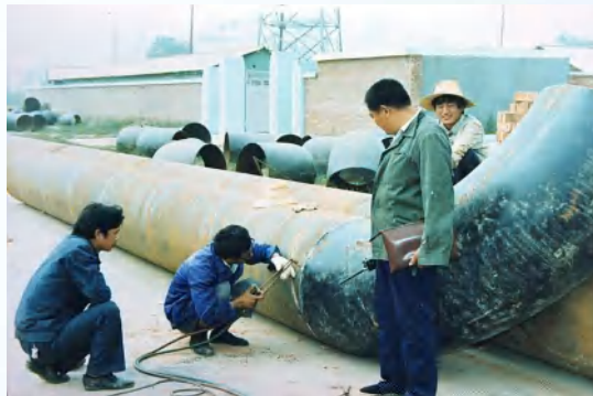
市城区供热一次管网敷设。
