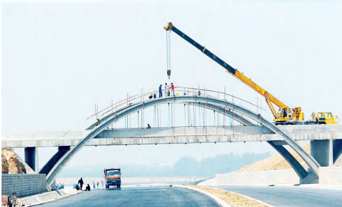
建设中的濮鹤高速。
