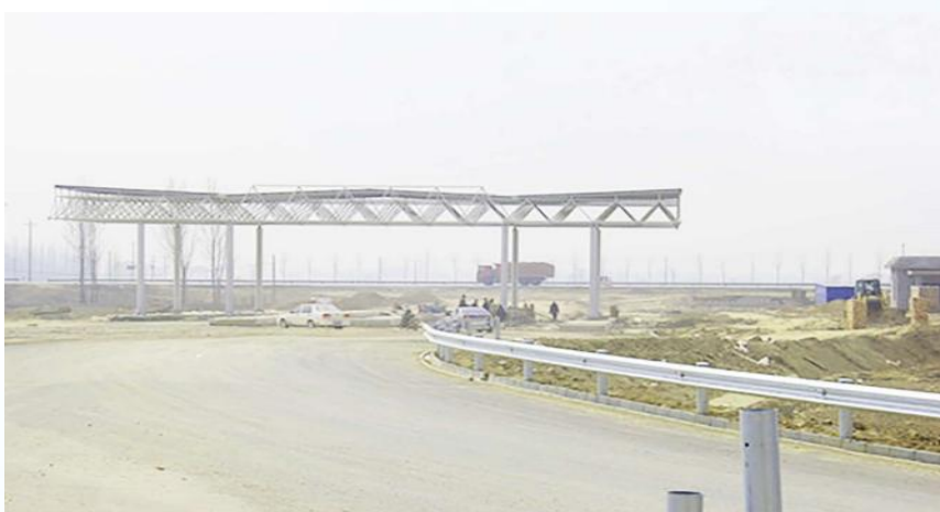
德州至商丘高速公路范县段开工。
