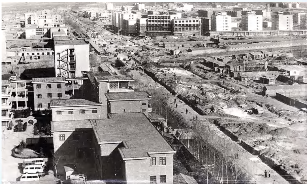
正在修建中的中原路。
