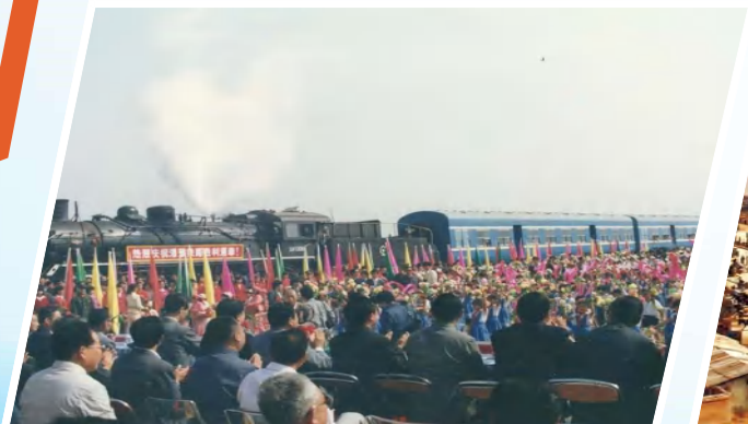
汤濮准轨铁路 9 月底全线贯通。
