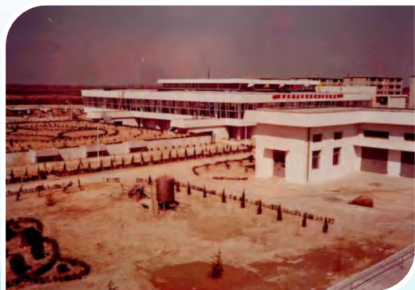
建设中的水厂。
