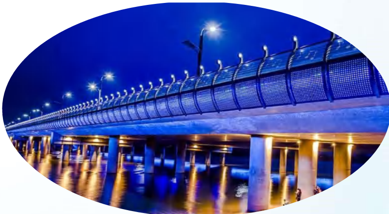
8月3日,我市第一座跨湖音乐大桥——卫都路跨湖大桥及引桥主车道完工通车。
