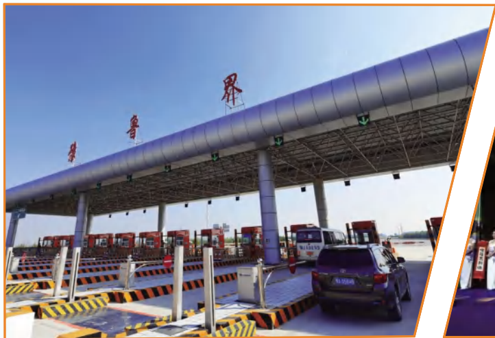
9月28日,南(乐)林(州)高速公路豫鲁省界收费站正式运营,标志着南林高速公路全线贯通,实现与山东高速公路联网联通。
