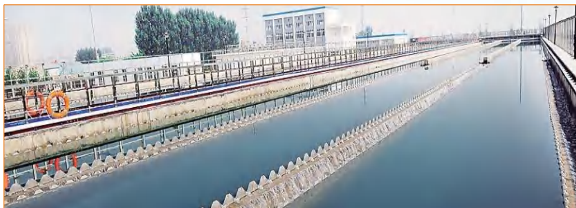
6月22日,市城区丹江水供用启动。市城区和中原油田基地由双水源提升至三水源保障。
