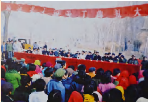
引黄供水工程预沉池 3 月在濮阳县渠村乡开工。
