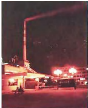
12月16日22时,市热电厂一号机组发电并网成功。图为市热电厂夜景。
