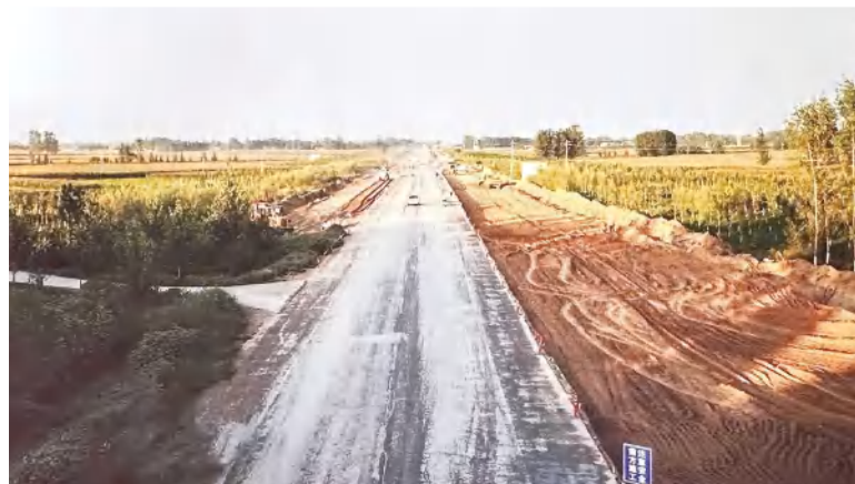
国道 106 改建施工现场。
