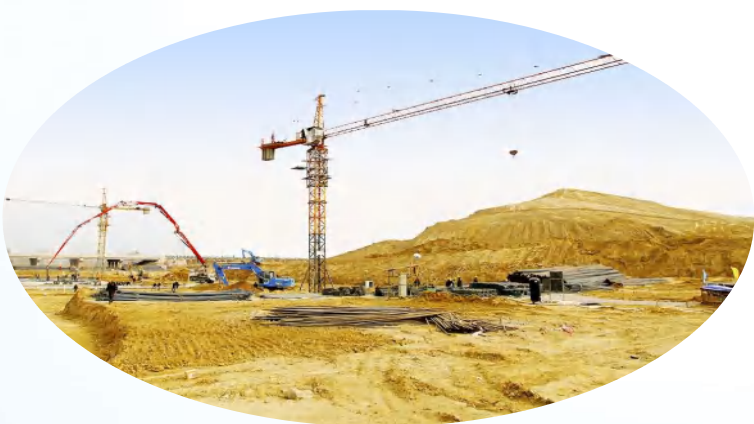
3月2日,市城乡一体化示范区开州路隧道施工现场。
