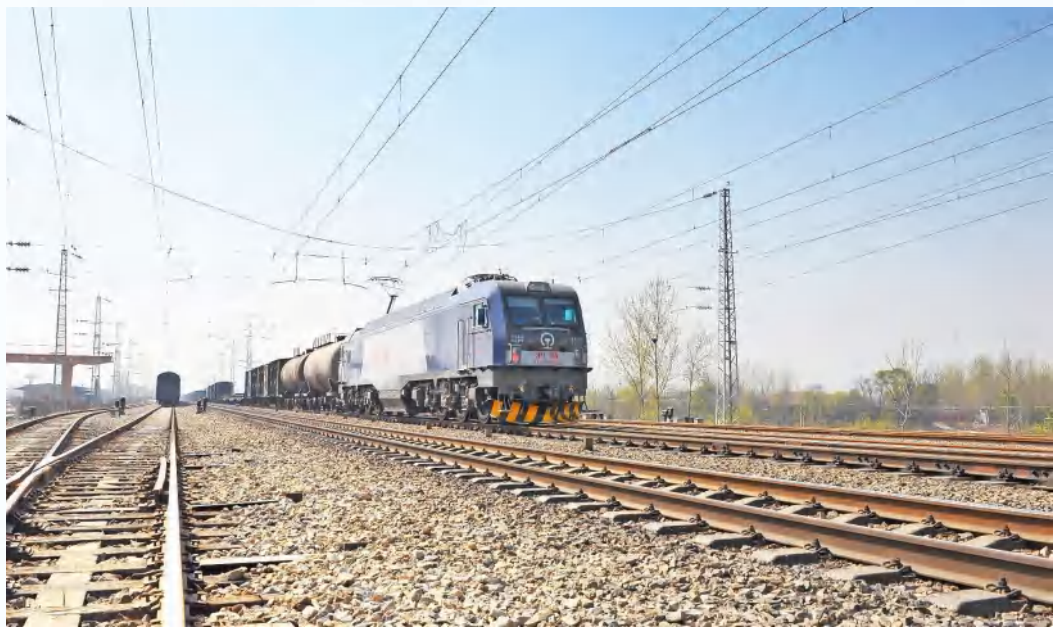
汤台铁路正线胜利贯通。
