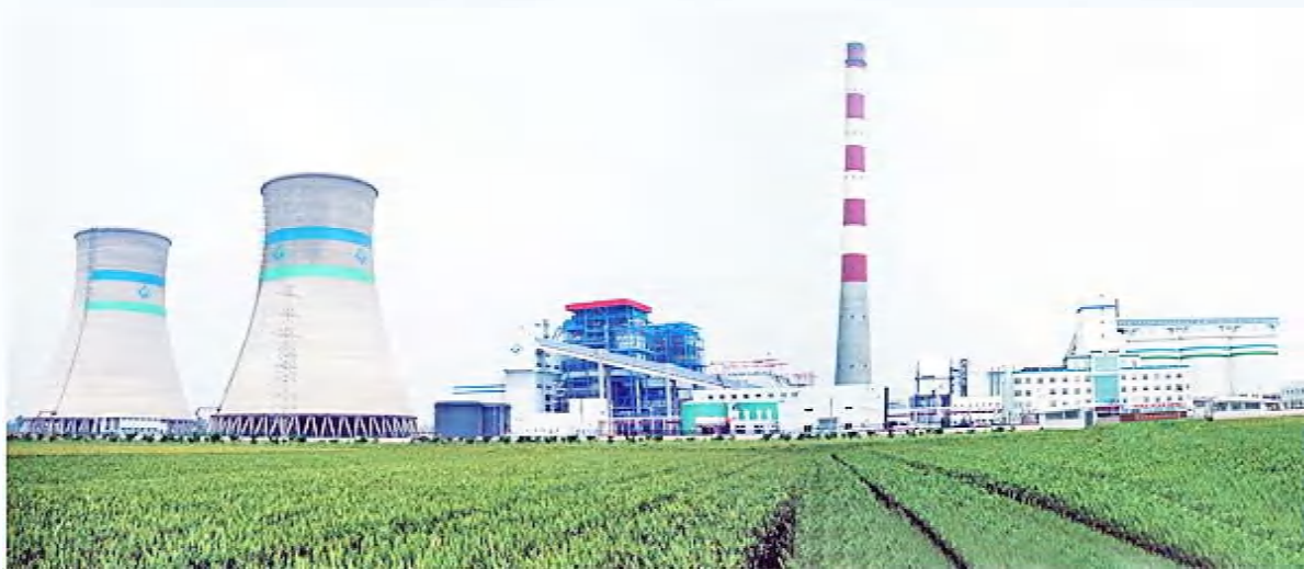
4月28日上午,国电濮阳热电2×20万千瓦热电项目一号机组举行投产庆典典礼,这标志着该项目正式进入商业运行。
