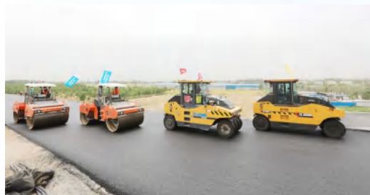
3月22日,濮阳至卫辉高速公路濮阳段正式开工建设,图为濮阳至卫辉高速公路濮阳段路面摊铺碾压现场。
