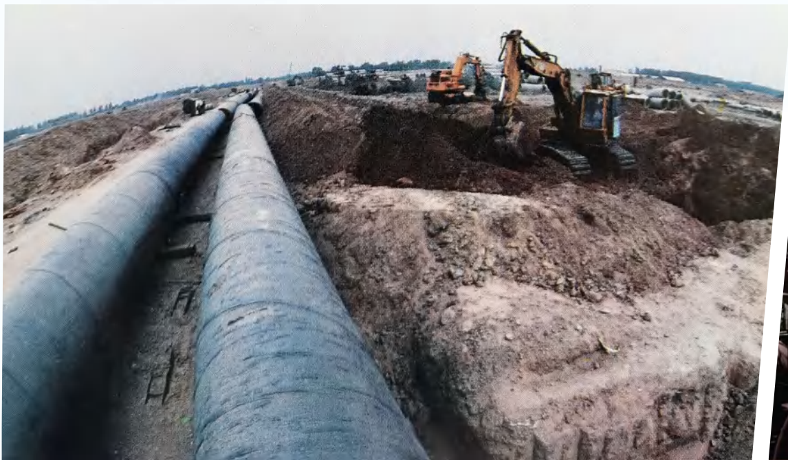
国务院正式批准在我市兴建中原 14 万吨乙烯工程。图为工程建设初期工地。
