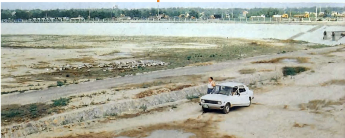
建设中的西水坡调节池水库。
